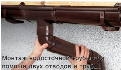
Монтаж водосточной трубы при помощи двух отводов и трубы-
