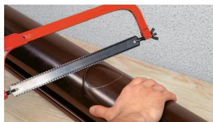
12. Снять с желоба воронку и ножковкой для металла вырезать отверстие (по обозначенной линии).
